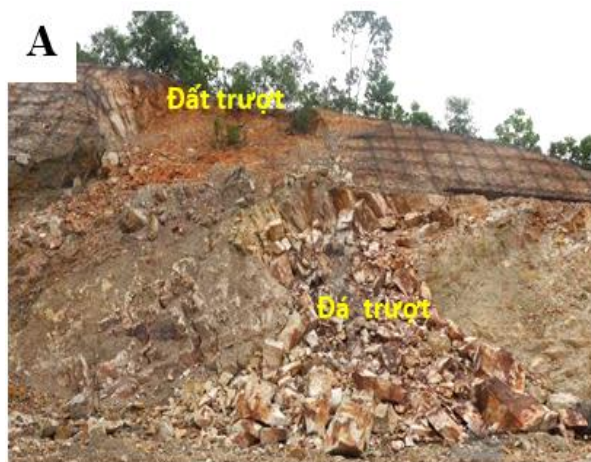
Hình 7. A. Hiện tượng đá trượt và đất trượt dọc vách taluy đường quan sát được ở Chiêm Sơn. Chú ý phần trên của vết lộ đã được gia cố bằng lưới thép để chống trượt nhưng hệ thống gia cố này không hiệu quả và bị phá hủy. B. Hiện tượng xói lở xảy ra dọc 1 nhánh của Sông Thu Bồn đoạn gần Hiệp Đức.
